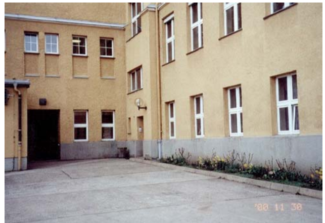
Abbildung 4: Eingangsbereich zum Speiseraum und zum Treppenhaus A
