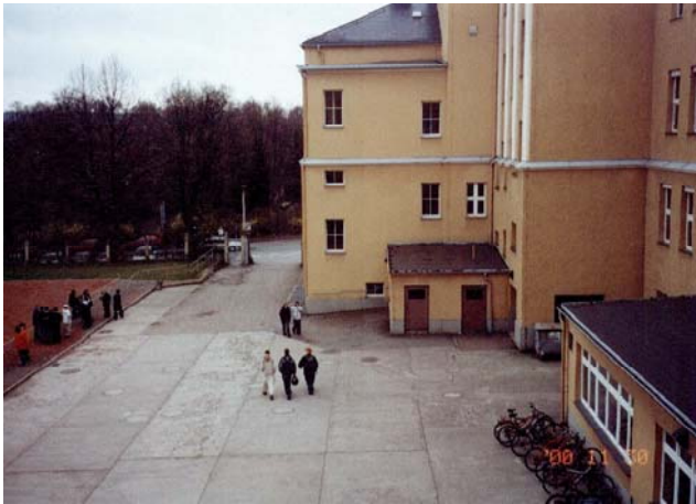
Abbildung 1: Tor zur Chamissostraße, Gebäudeflügel mit Turnhalle und Aula, links der Sportplatz
